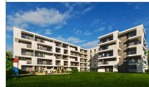
BUDYNEK MIESZKALNY WIELORODZINNY
