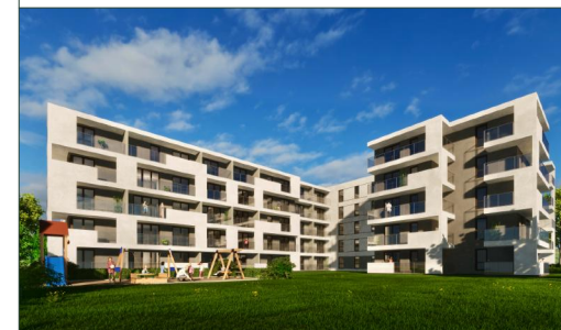
BUDYNEK MIESZKALNY WIELORODZINNY
