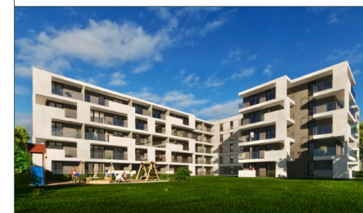
BUDYNEK MIESZKALNY WIELORODZINNY
