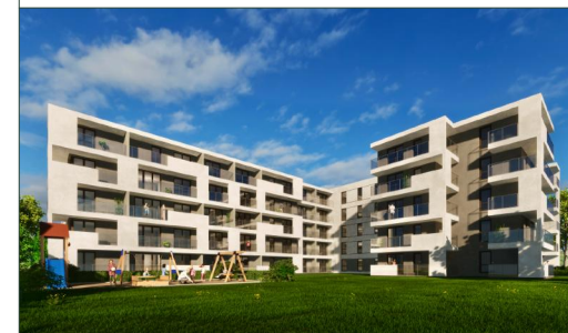
BUDYNEK MIESZKALNY WIELORODZINNY
